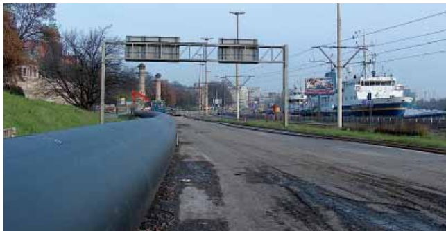
Fot. 6. Koniec rury PE 1033 wyłożony na ulicy Jana z Kolna, podczas wciągania w otwór pod Odrą
