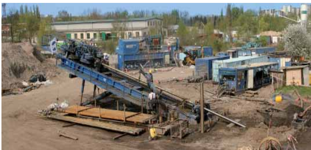
Fot. 13. Wiertnia 250 t na stanowisku roboczym w rejonie oczyszczalni „Pomorzany”.
