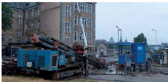
Fot. 2. Wiercenie otworów pilotowych pod Odrą wiertnią DD-90
