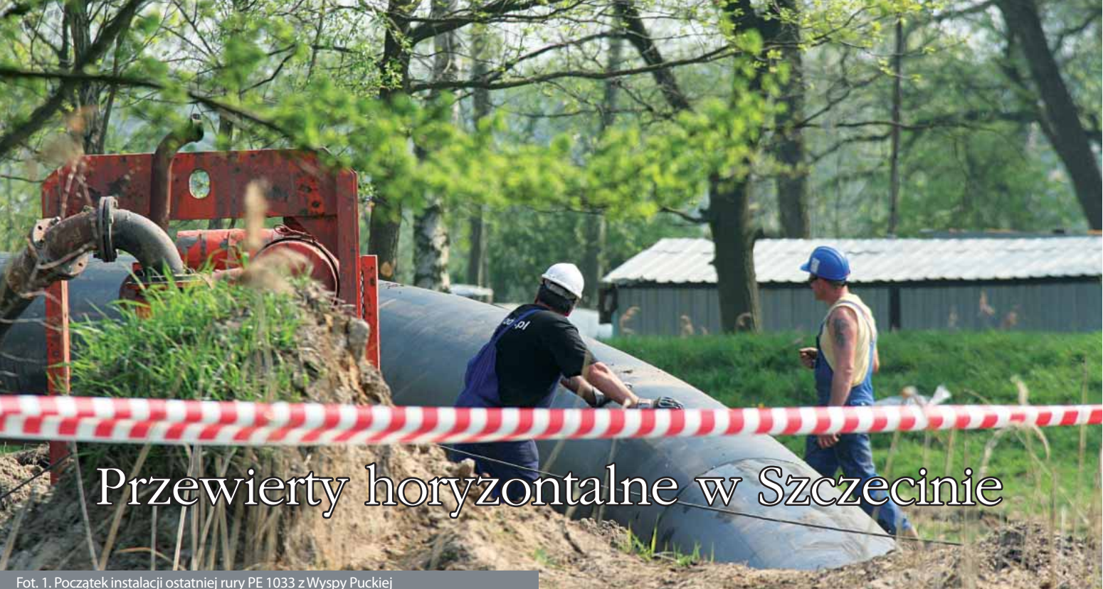
Fot. 1. Początek instalacji ostatniej rury PE 1033 z Wyspy Puckiej
