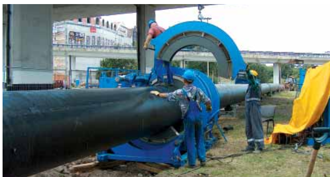
Fot. 5. Zgrzewanie pierwszej nitki rury PE 1033 pod Trasą Zamkową.
