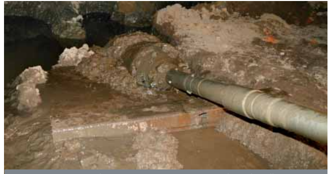
Fot. 15. Koniec instalacji ostatniej rury za rozwiertakiem baryłkowym.
