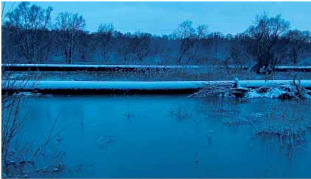
Fot. 12. Strona rurowa w czasie przyboru wody w Odrze
