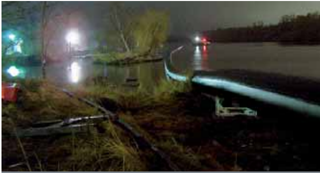
Fot. 10. Półmetek instalacji rury z wody pod Kanałem Parnickim.
