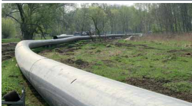
Fot. 7. Rurę polietylenową można wykładać w terenie relatywnie małymi łukami.
