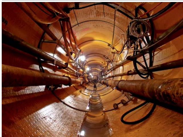
Fot. 4. Wnętrze instalacji mikrotunelowej
